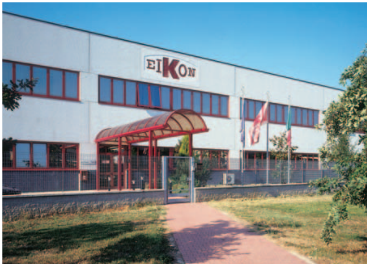
Edificio industriale - Rosate (Milano)
