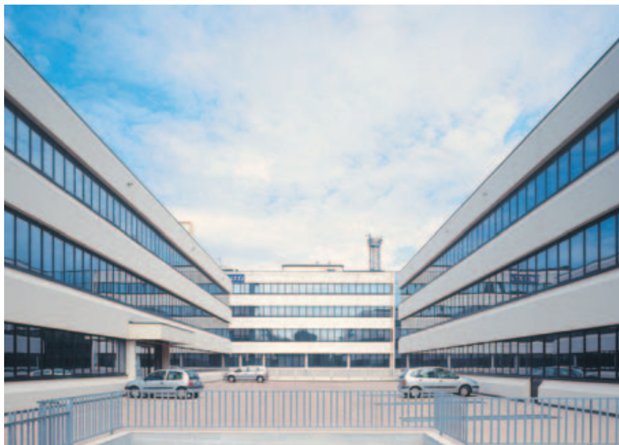
Palazzina uffici - Vimodrone (Milano)
