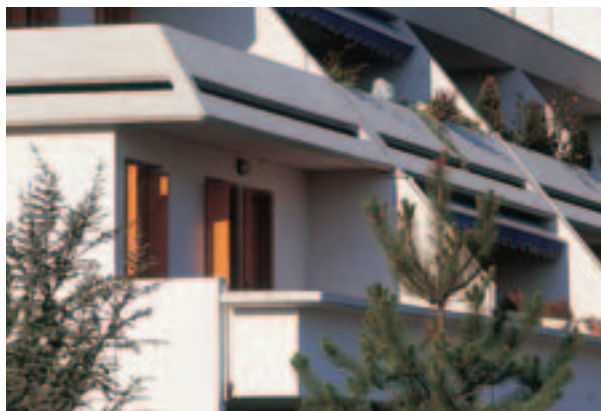
Edificio residenziale - Erbusco (Brescia)
