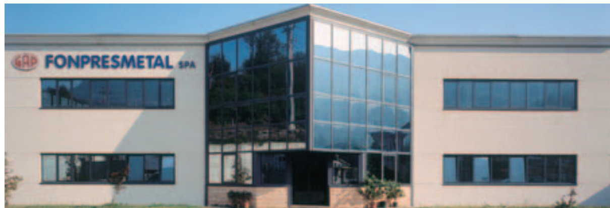
Edificio industriale Fonpresmetal - Bione (Brescia)
