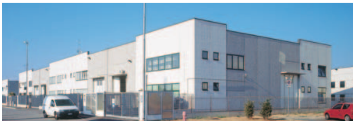
Edificio industriale - Brignano Gera D'Adda (Bergamo)
