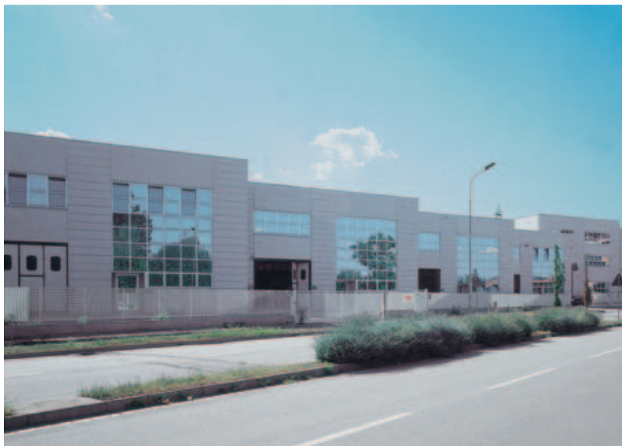
Edificio Industriale - Gallarate (Varese)
