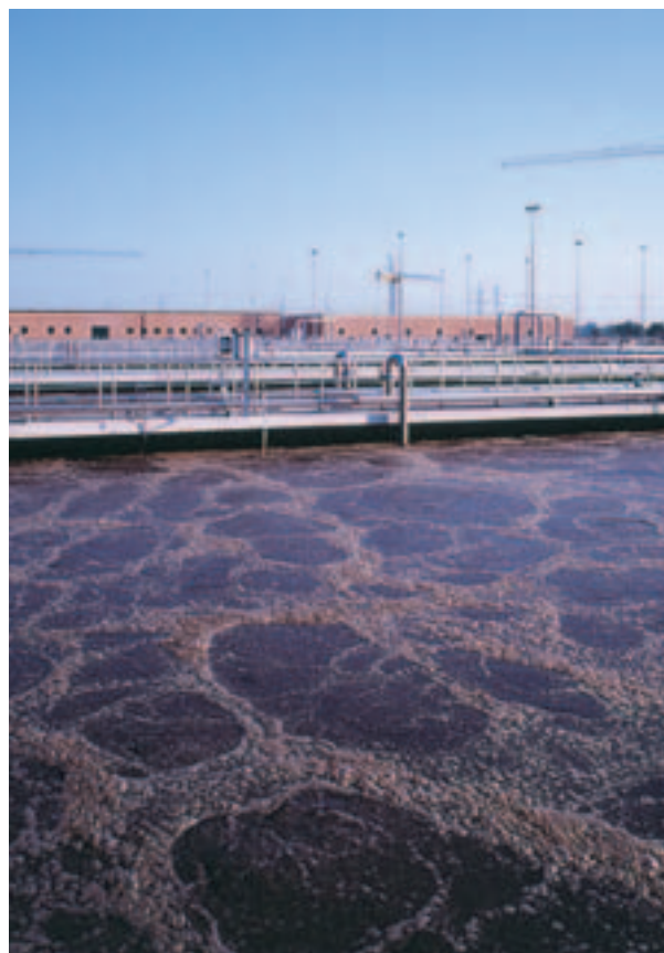
Depuratore - Nosedo (Milano)
