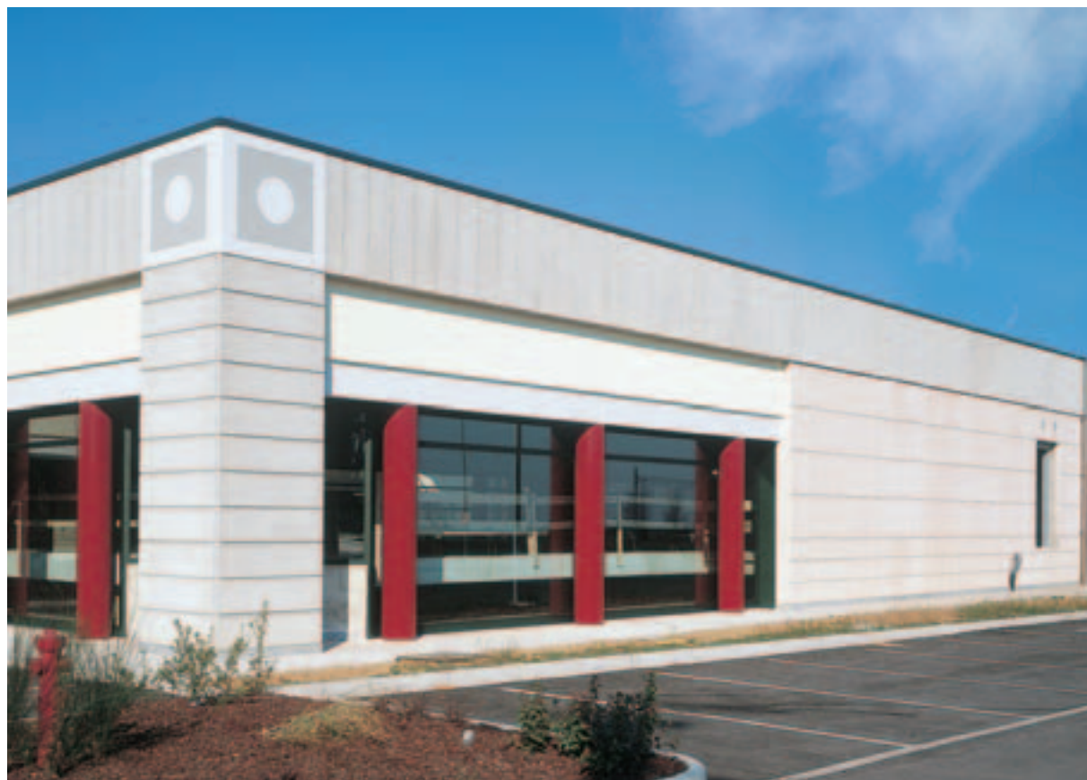
Edificio commerciale Penny Market - Medolago (Bergamo)
