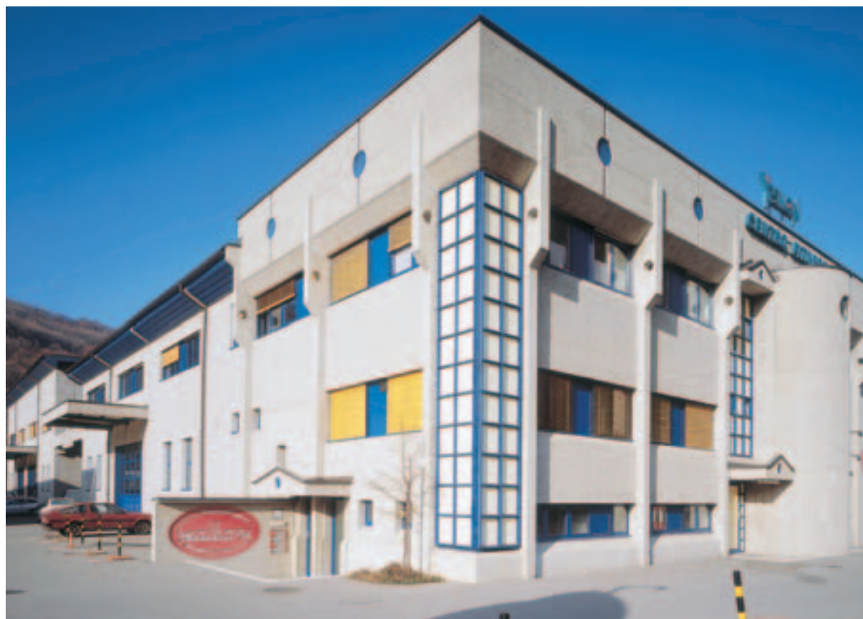
Edificio Industriale Galbani - Lugano (Svizzera)
