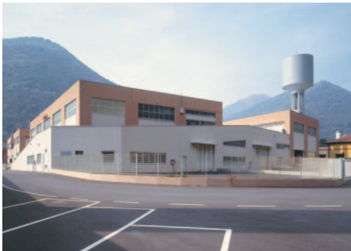
Edificio industriale - Gardone Val Trompia (Brescia)
