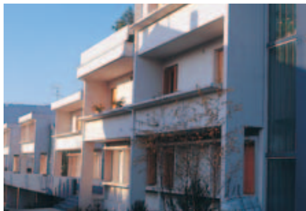
Edificio residenziale - Erbusco (Brescia)
