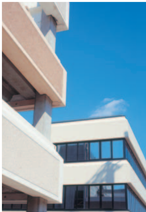
Palazzina uffici - Vimodrone (Milano)
